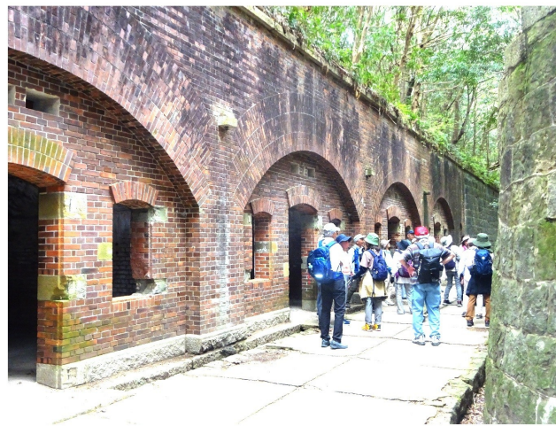
<第3砲台跡> 5つある砲台の中で最主力の砲台
